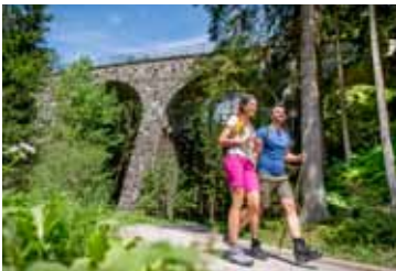
Viadukt beim Weyrerteich
